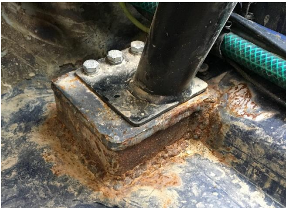
Rohr auf Bodenplatte
